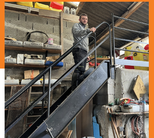
Le Gaec de la Mure a remplacé une échelle peu stable par un large escalier, permettant de ranger du gros matériel en toute sécurité.
